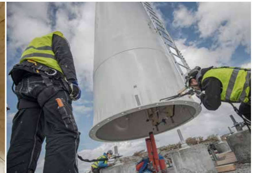
Modvions vindkraftstorn av trä sätts upp på Resö utanför Göteborg. Foto: Modvion
