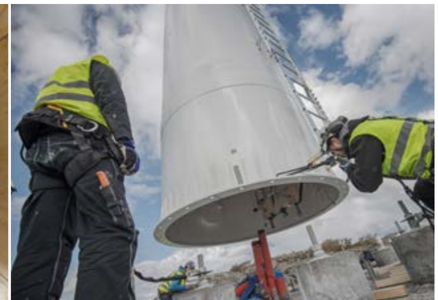
Modvions vindmølletårn i tre settes opp på Resö utenfor Göteborg. Foto: Modvion
